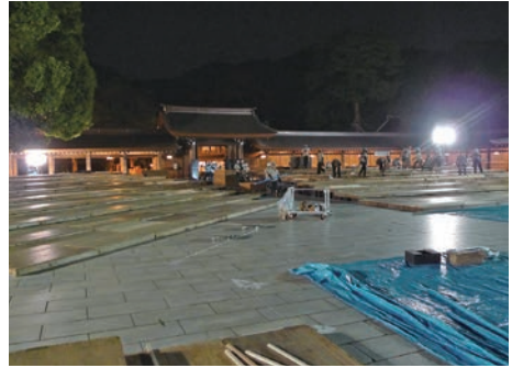
前日深夜から仮設スタンドの組み立て (安藤ハザマ 撮影)
