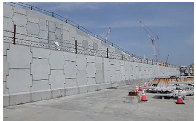
完成した防潮堤の一部
