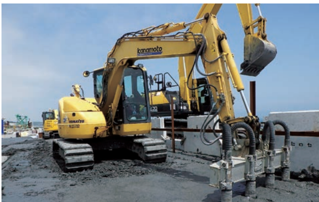
アッシュクリートの施工状況
