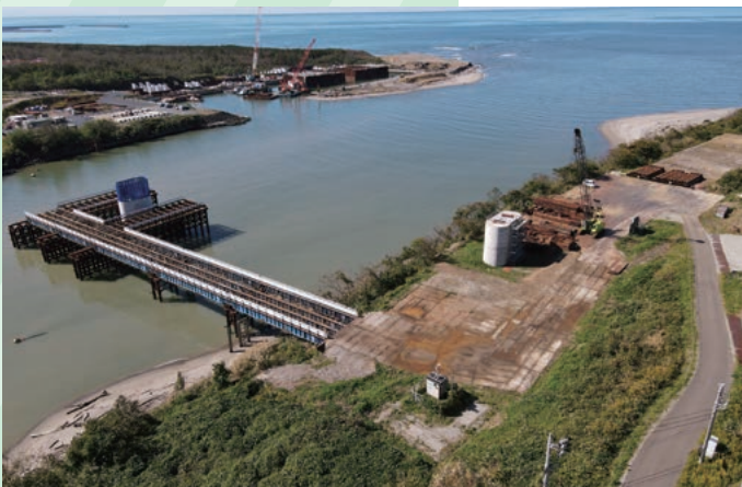
新野積橋橋脚
