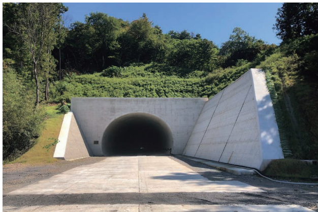
工事名：米原バイパス彦根トンネル工事 発注者：国土交通省近畿地方整備局
