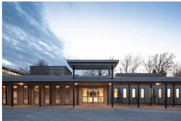
工事名：東京都東村山福祉園（2）改築工事 発注者：東京都
