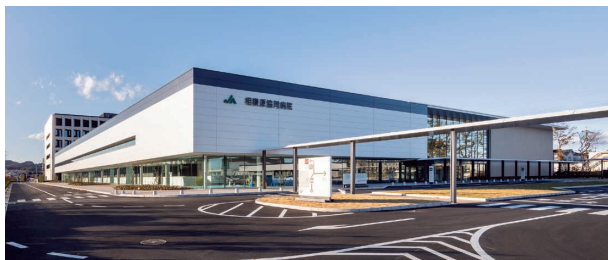
工事名：(仮称) JA神奈川県厚生連 相模原協同病院移転新築工事 発注者：全国農業協同組合連合会
