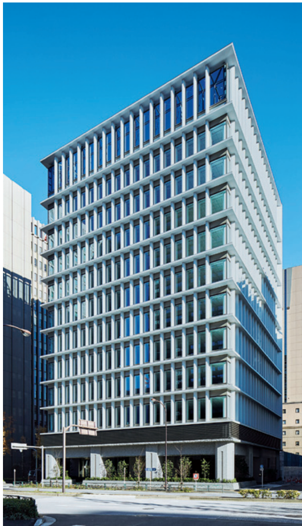
工事名：日比谷ビルディング新築工事 発注者：清和綜合建物株式会社
