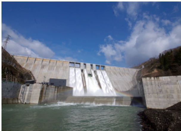
工事名：津軽ダム本体建設工事 発注者：国土交通省東北地方整備局
