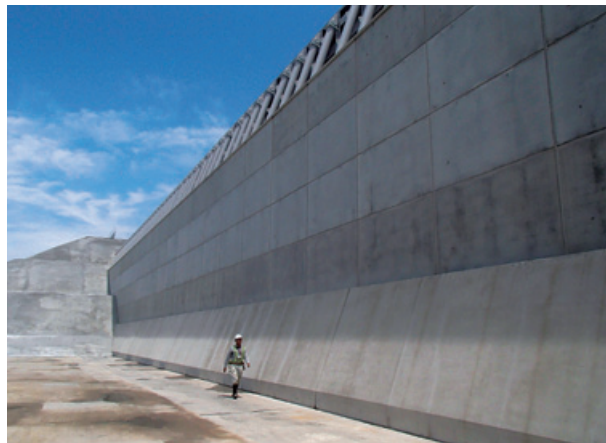
工事名：浜岡原子力発電所 防波壁設置工事の内上部工事（東工区） 発注者：中部電力株式会社
