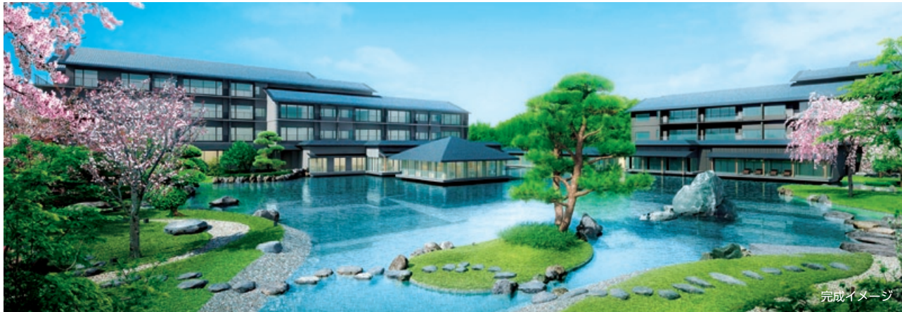
工事名：(仮称) エクシブ鳥羽別邸新築工事（三重県） 発注者：リゾートトラスト株式会社
