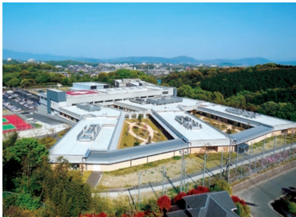
工事名：総合せき損センター新棟建築工事（福岡県） 発注者：独立行政法人労働者健康福祉機構
