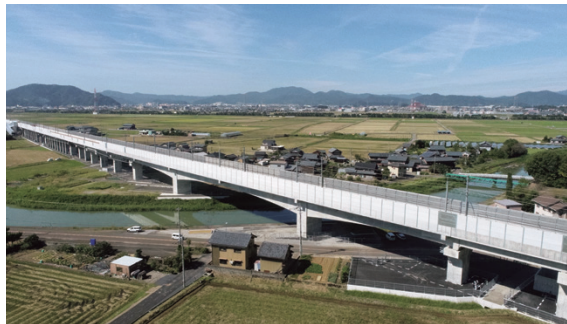
北陸新幹線、浅水川橋りょう他 発注者：独立行政法人鉄道建設・運輸施設整備支援機構
