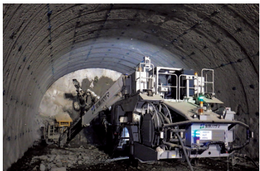
【令和3年度土木学会賞 技術賞Ⅰグループ 受賞】 玉島笠岡道路六条院トンネル工事 遠隔技術を活用したドリルジャンボでの施工
