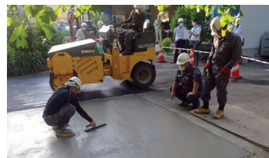
試験施工状況
