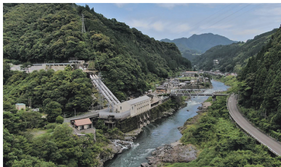
五ヶ瀬川発電所土木設備撤去工事一式及び土木設備改修工事一式 発注者：旭化成株式会社
