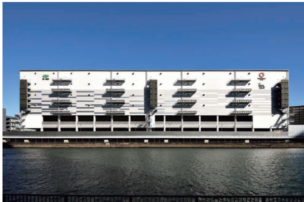
工事名：(仮称) Dプロジェクト江東深川新築工事 発注者：ディエイチ・アセット・ワン特定目的会社
