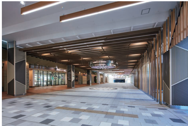
工事名：中山競馬場スタンドリフレッシュ（第2期）工事 発注者：日本中央競馬会
