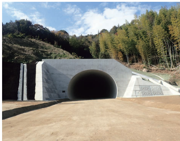
工事名：玉島笠岡道路六条院トンネル工事 発注者：国土交通省中国地方整備局
