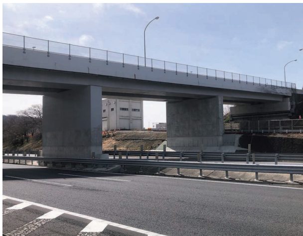
工事名：東北自動車道 極瀬第一橋（ロッキング橋脚）耐震補強工事 発注者：東日本高速道路株式会社
