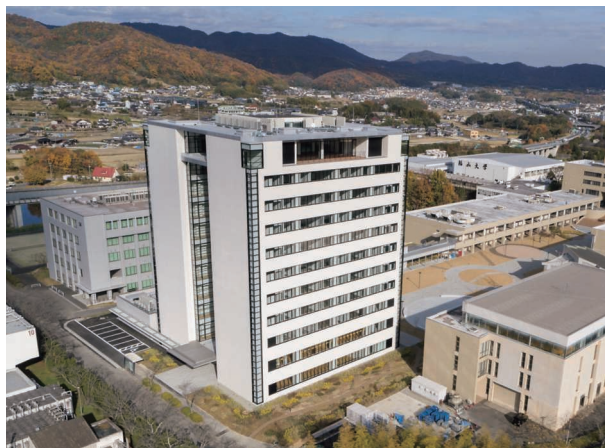
工事名：福山大学未来創造館新築工事その他工事 発注者：学校法人福山大学
