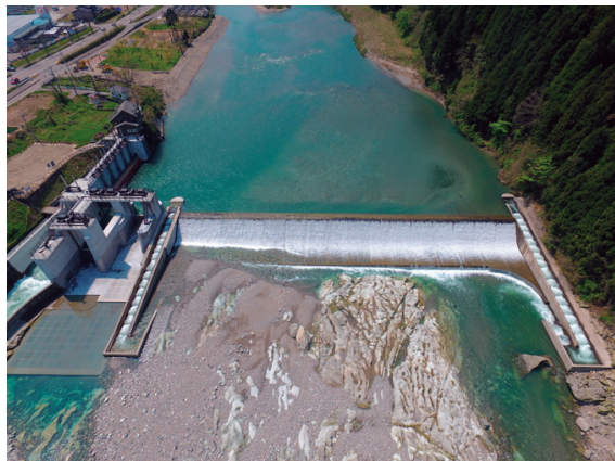
手取川流域農業水利事業 白山頭首工（二期）建設工事 発注者：農林水産省北陸農政局
