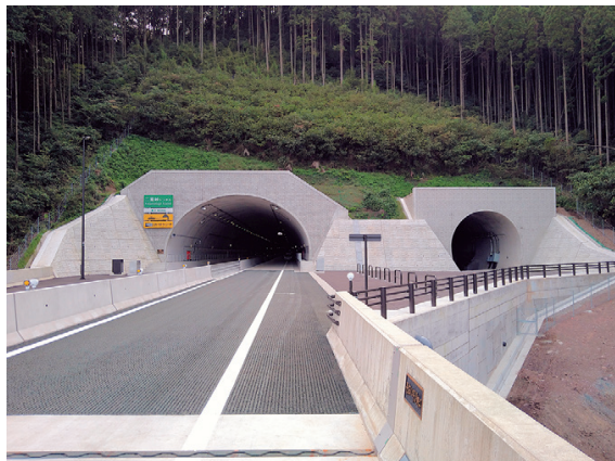
熊本57号災害復旧 二重峠トンネル（阿蘇工区）工事 発注者：国土交通省九州地方整備局
