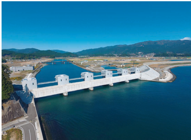
工事名：二級河川気仙川筋砂盛地区河川災害復旧（23災589号） 水門土木工事 発注者：岩手県
