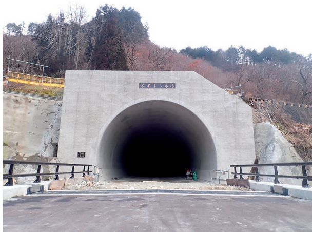
工事名：道路橋りょう整備（再復）工事（トンネル） 発注者：福島県
