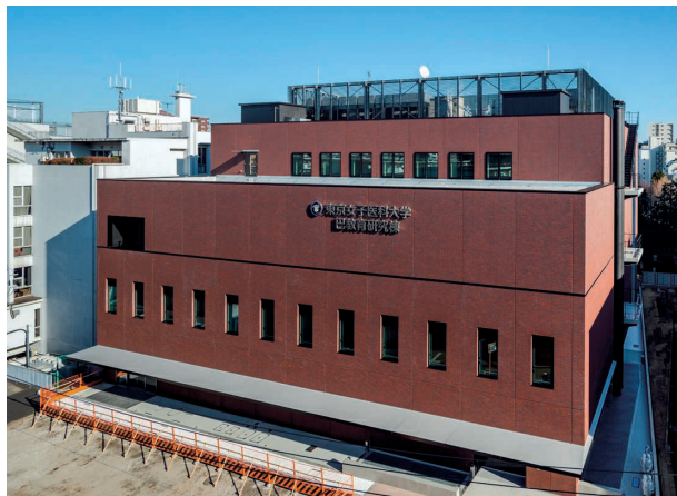
工事名：東京女子医科大学河田町キャンパス（仮称）新校舎棟2新築工事 発注者：学校法人東京女子医科大学
