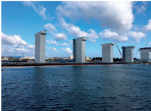
工事名：平成29-31年度 沖洲高架橋下部（P19-P1）工事 発注者：国土交通省四国地方整備局
