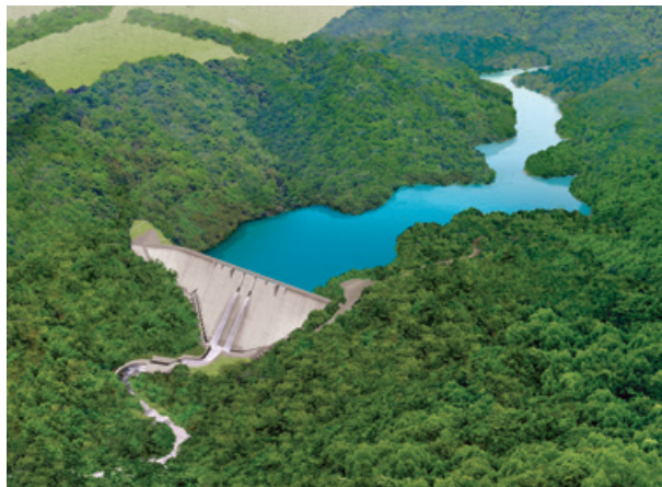
工事名：駒込ダム本体建設工事 発注者：青森県東青地域県民局
