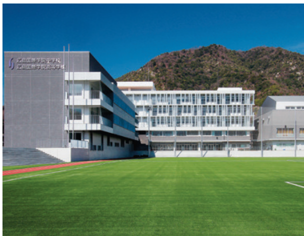
工事名：広島国際学院高等学校校舎等改築工事 発注者：学校法人広島国際学院
