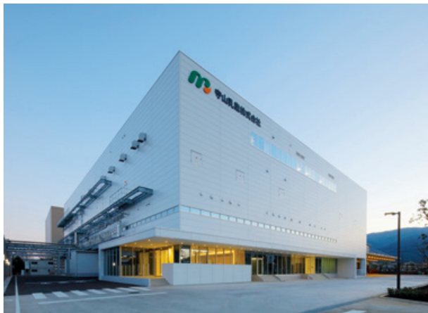
工事名：(仮称) 守山乳業株式会社神奈川工場新築工事 発注者：守山乳業株式会社
