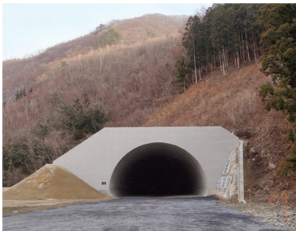
工事名：国道106号 箱石地区道路工事 発注者：国土交通省東北地方整備局
