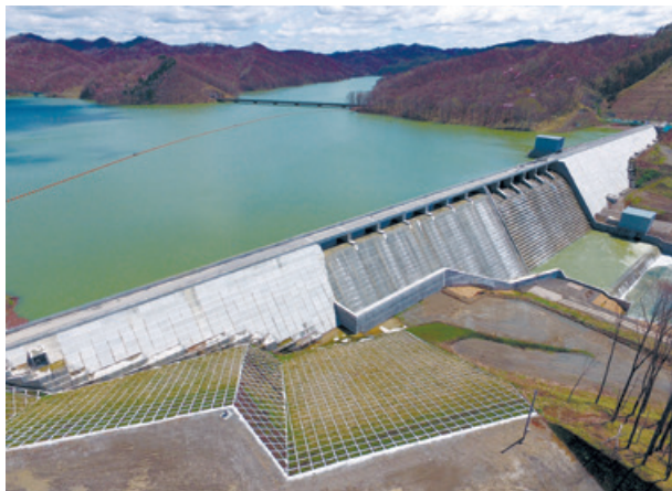
工事名：厚幌ダム建設事業ダム本体工事 発注者：北海道胆振総合振興局
