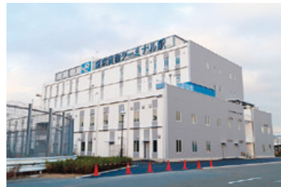
当社設計・施工による「東京貨物ターミナル駅事務所新築工事」（発注者：日本貨物鉄道株式会社）にカーボンフットプリント（CFP）とCFPPに基づくカーボン・オフセットを適用
