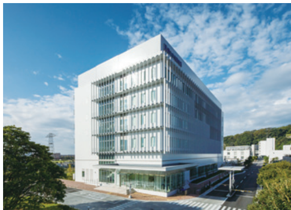
横須賀地区 新研究棟（仮称）新築工事 発注者：一般財団法人 電力中央研究所
