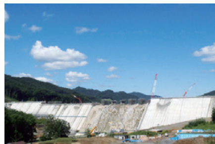
CSG打設が完了した厚幌ダム
