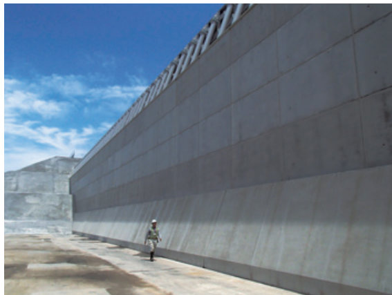
浜岡原子力発電所 防波壁設置工事の内上部工工事（東工区） 発注者：中部電力株式会社
