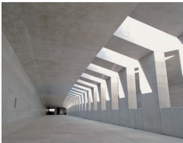
工事名：北国分地区函渠その2工事（千葉県） 発注者：国土交通省関東地方整備局
