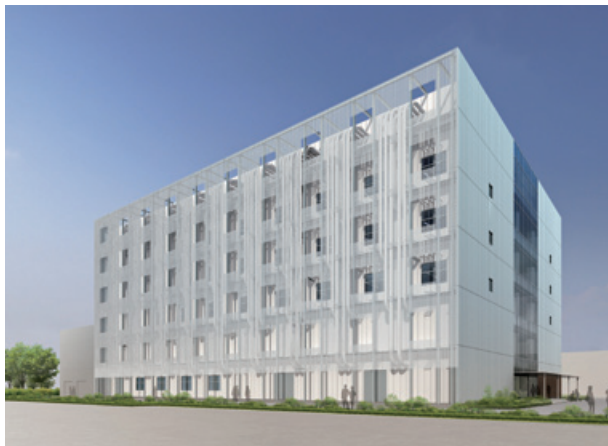
工事名：(仮称) 研究開発棟建設工事（神奈川県） 発注者：株式会社リコー
