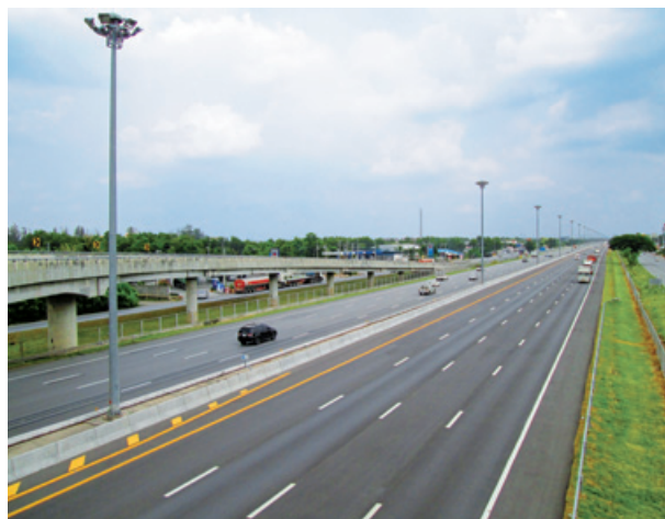
工事名：東部外環状道路（国道九号線）改修計画（タイ） 発注者：タイ王国運輸省道路局（JICA ODA）
