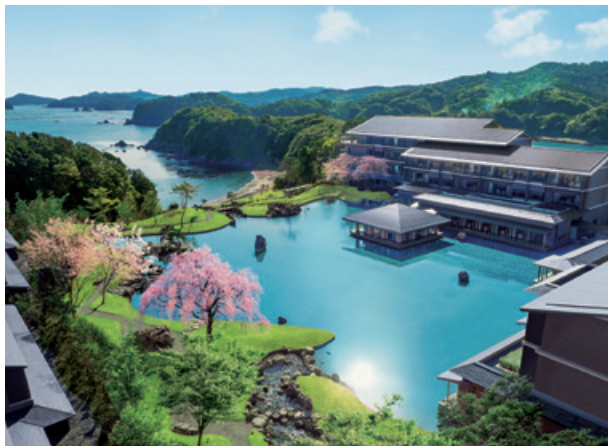
工事名：(仮称) エクシブ鳥羽別邸新築工事（三重県） 発注者：リゾートトラスト株式会社
