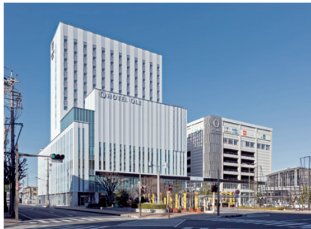
工事名：(仮称) 藤枝駅南口開発B街区新築工事（静岡県） 発注者：有限会社新日邦
