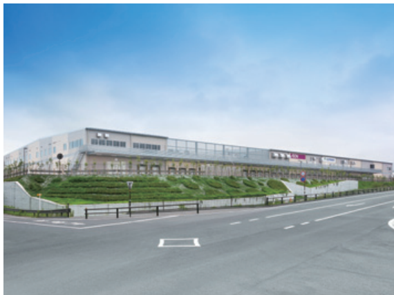
工事名：(仮称) イオン長泉PC新築工事（静岡県） 発注者：鴻池運輸株式会社
