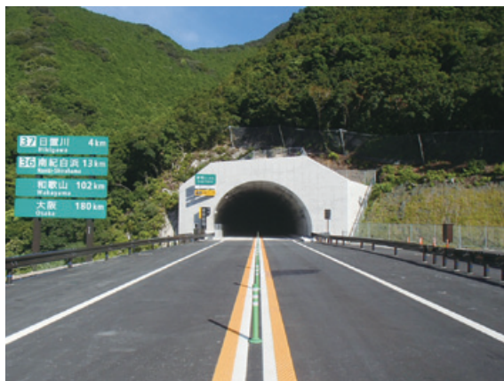
工事名：近畿自動車道紀勢線安宅トンネル工事（和歌山県） 発注者：国土交通省近畿地方整備局
