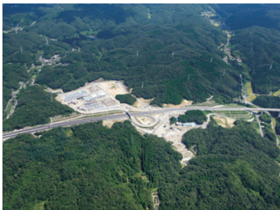
工事名：第二東名高速道路 岡崎サービスエリア工事（愛知県） 発注者：中日本高速道路株式会社
