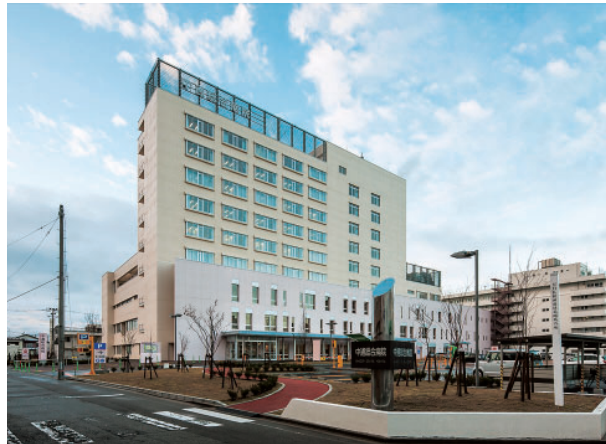
工事名：中通総合病院新築及び改修工事（秋田県） 発注者：社会医療法人明和会
