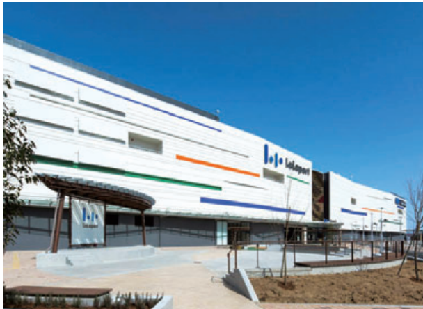
工事名：ららぽーと富士見新築工事（埼玉県） 発注者：三井不動産株式会社
