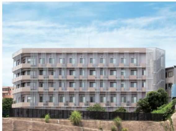
工事名：佐世保中央病院南棟増改築工事（長崎県） 発注者：社会医療法人財団 白十字会
