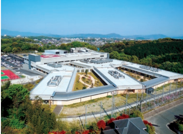
工事名：総合せき損センター新棟建築工事（福岡県） 発注者：独立行政法人労働者健康福祉機構
