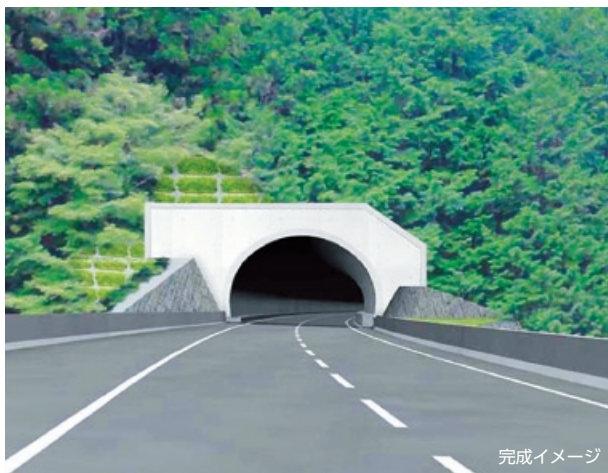
工事名：平成25年度 佐久間道路佐久間第2トンネル工事（静岡県） 発注者：国土交通省中部地方整備局
