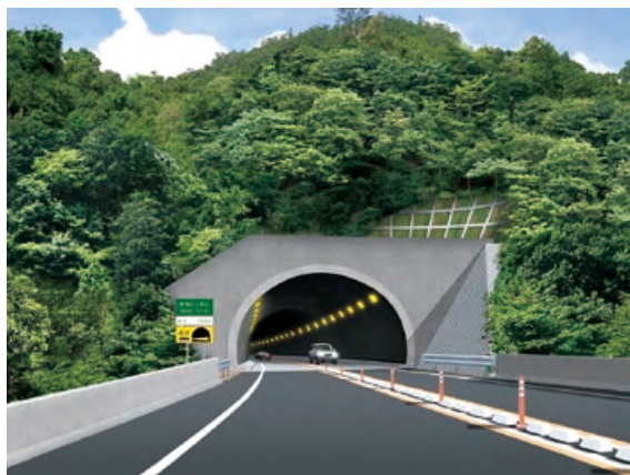
工事名：丹波綾部道路和知トンネル工事（京都府） 発注者：国土交通省近畿地方整備局
