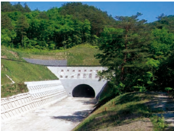
工事名：国道45号尾肝要トンネル（北工区）工事（岩手県） 発注者：国土交通省東北地方整備局
