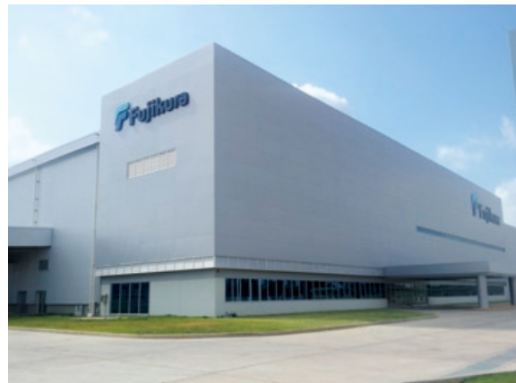
工事名：フジクラ タイランド カビンブリ工場新築工事（タイ） 発注者：Fujikura Electronics (Thailand) Ltd.
