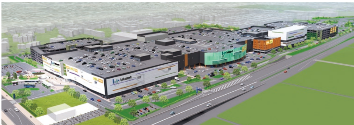
工事名：(仮称)ららぽーと富士見新築工事（埼玉県） 発注者：三井不動産株式会社
