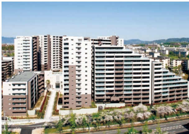
工事名：千里桃山台第2団地住宅建替え事業に伴う建設工事（大阪府） 発注者：京阪電気鉄道株式会社・大和ハウス工業株式会社・住友商事株式会社・株式会社コスモスインシア共同企業体
