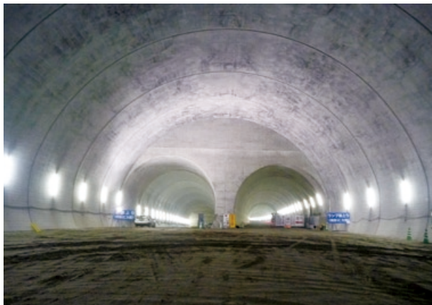
工事名：鹿児島3号 新武岡トンネル新設（2期）工事（鹿児島県） 発注者：国土交通省九州地方整備局
