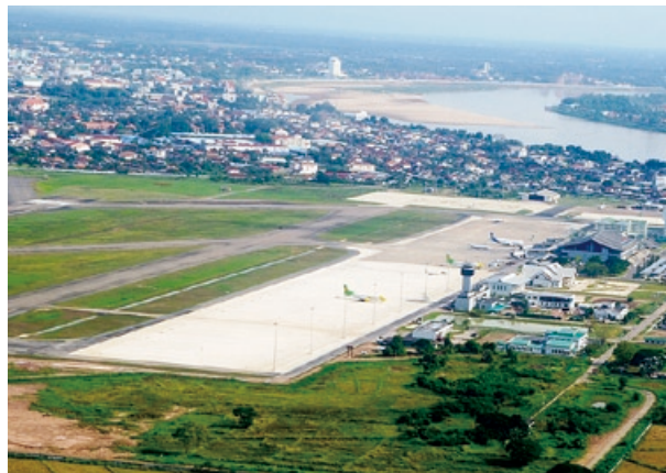
工事名：ピエンチャン国際空港拡張計画（ラオス） 発注者：ラオス人民民主共和国公共事業運輸省航空局
