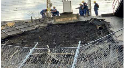
のり面下から
