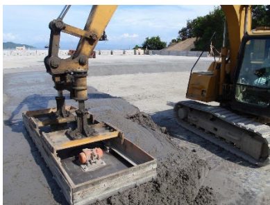
盛土材（人工地盤）
