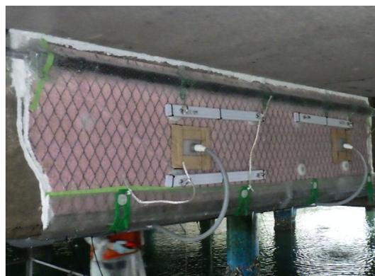
海上栈橋横桁への適用状況（脱塩）
