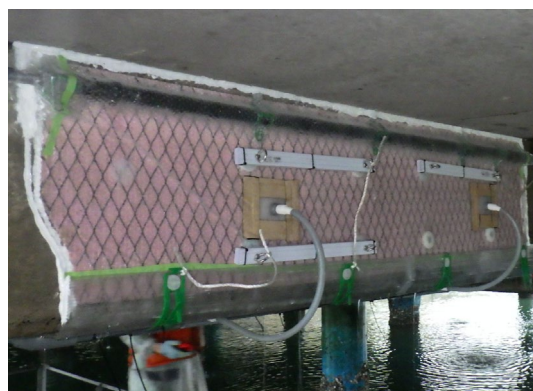
海上栈橋横桁への適用状況（脱塩）
