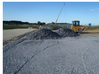
路盤材（破碎材）
