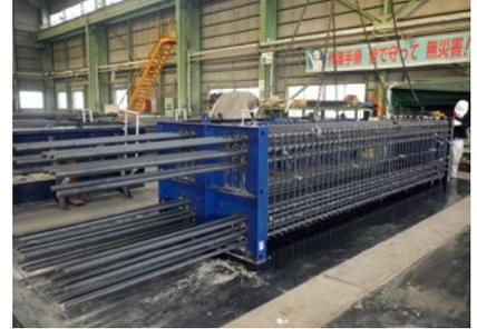
2 型枠組立／鉄筋・金物取付
