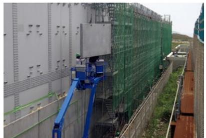
浜岡原子力発電所(防波壁防食パネル)
