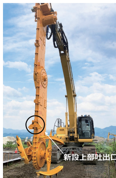
WILL-m工法施工機械全景
