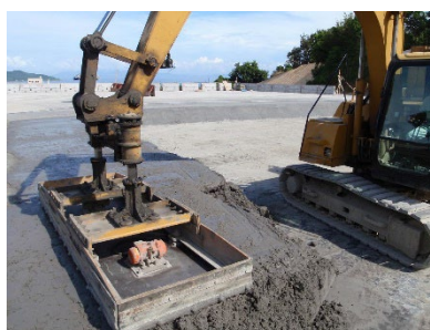
盛土材（人工地盤）
