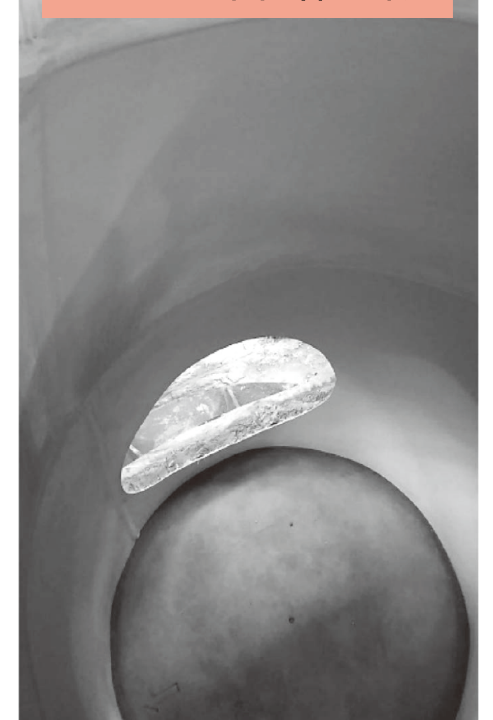
スラスラ工法で修繕した1号マンホール試験体
