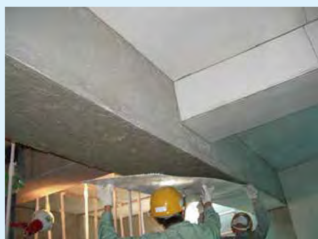
シート差込み状況
