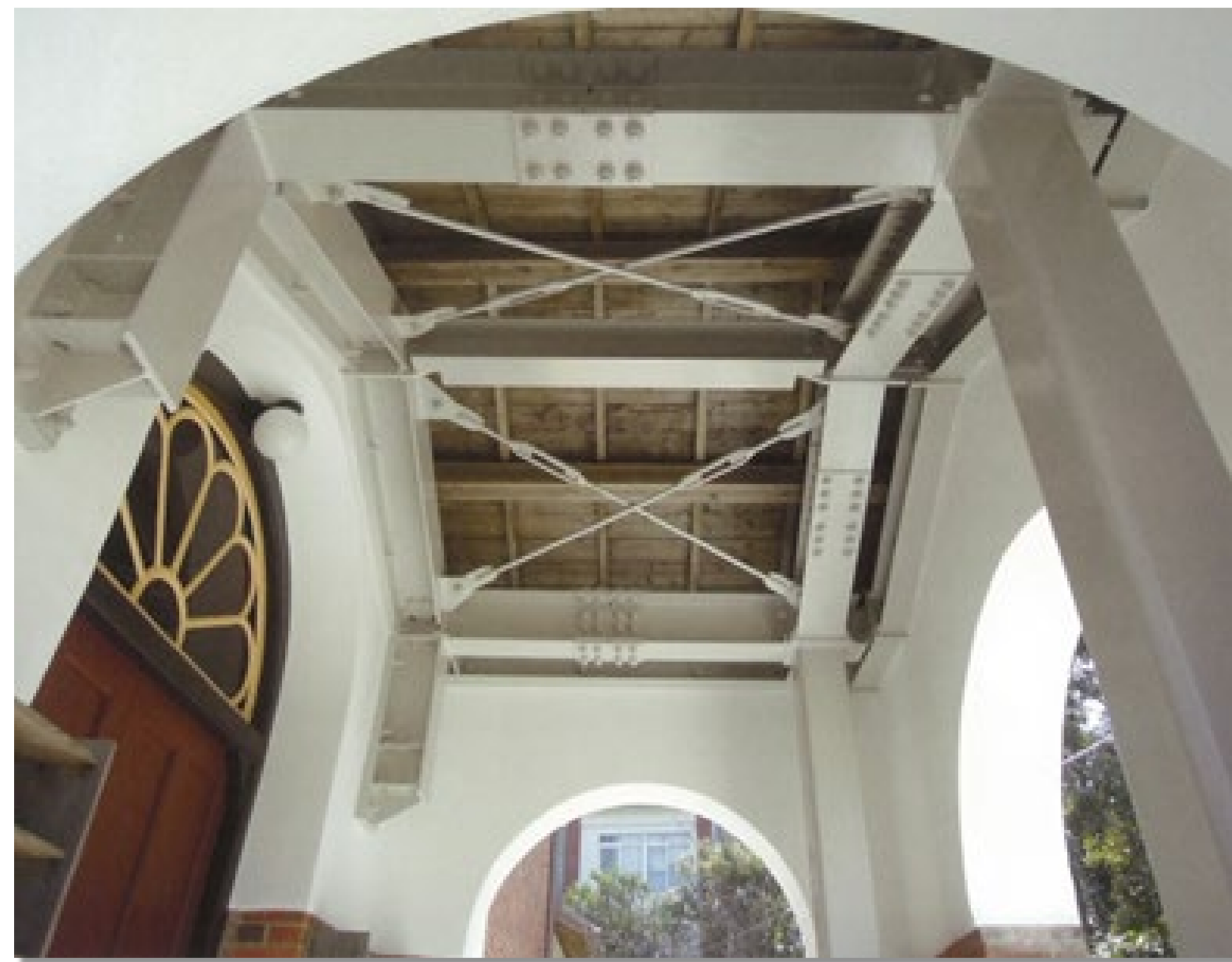
側玄関鉄骨フレーム
