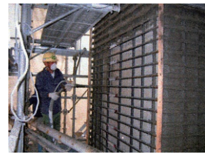
モルタル吹付け
