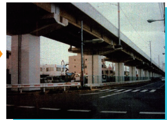
施工完成状況
