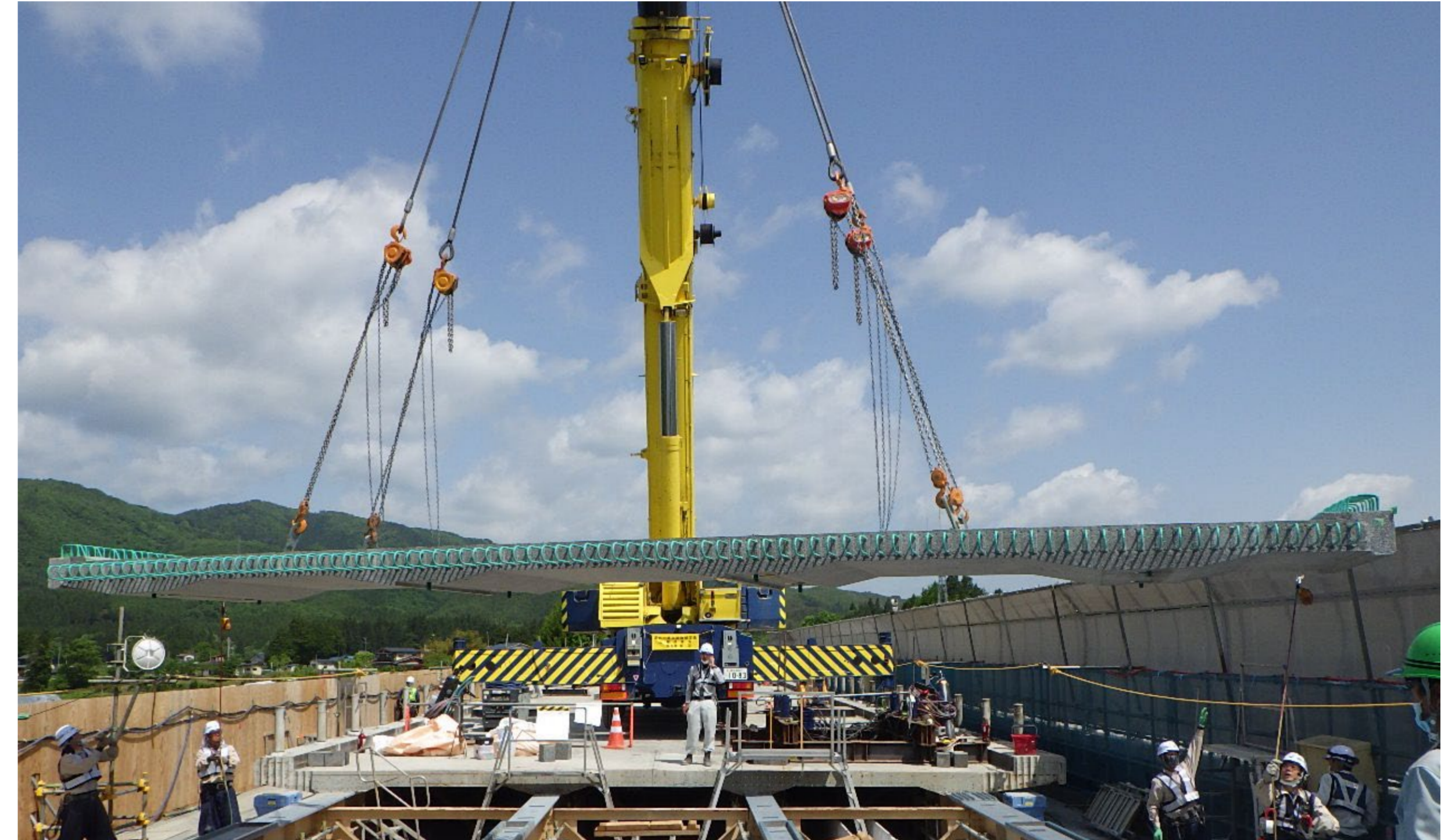
写真1 チェンブロックを使用した姿勢制御
