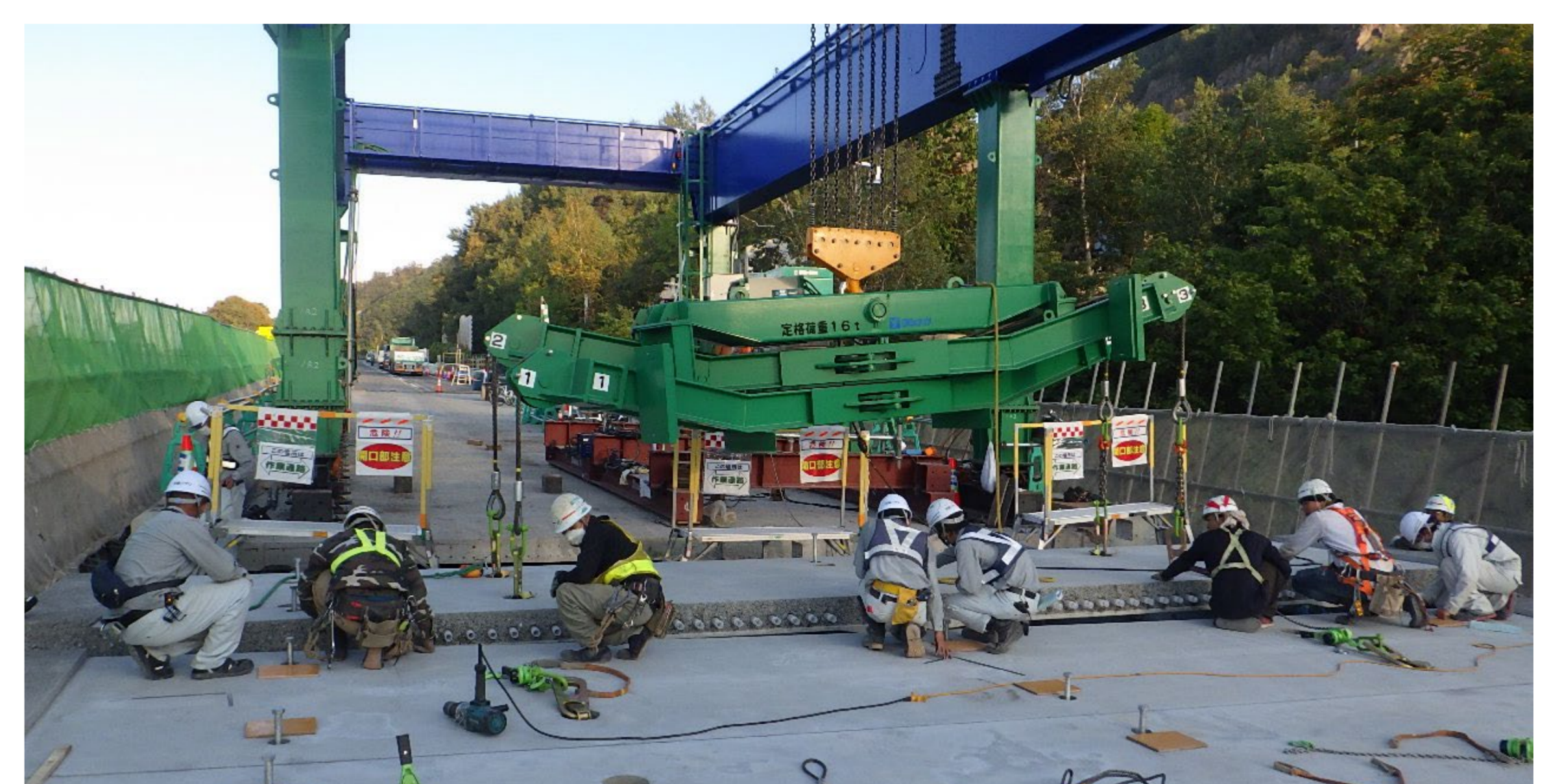
写真2 実橋梁での施工状況
