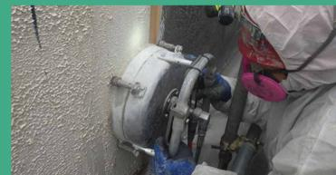
外壁塗膜材除去(アスベスト除去)
