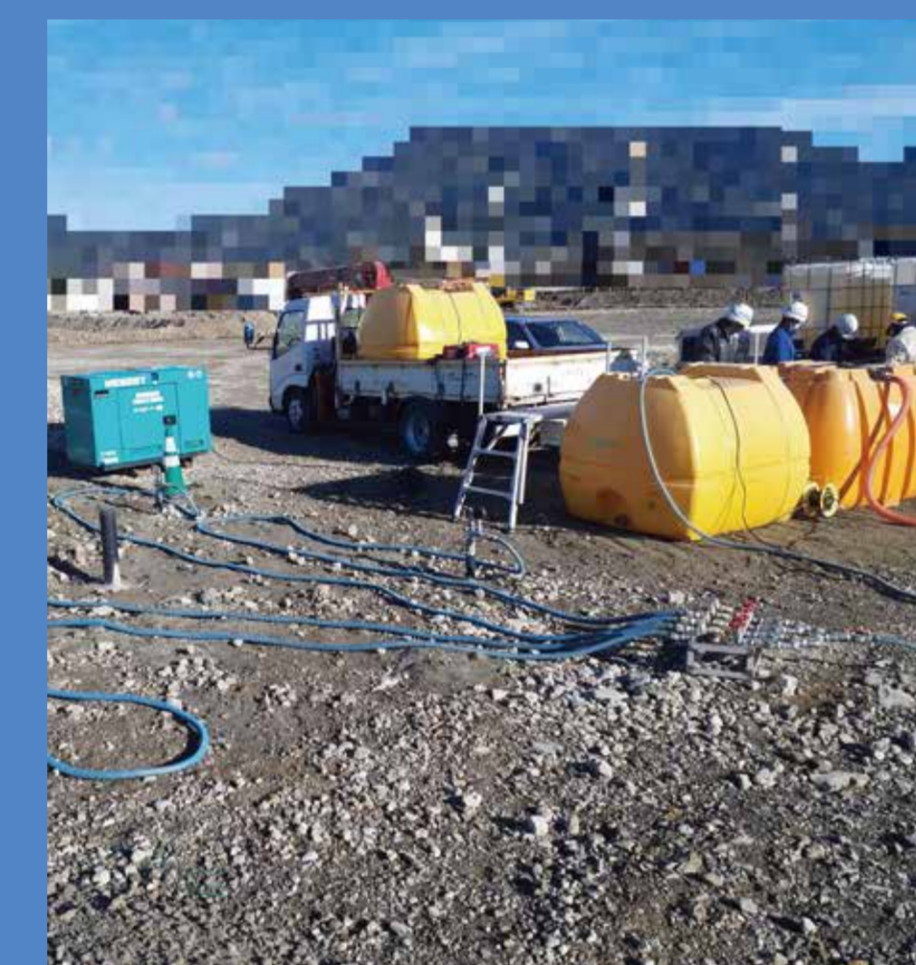
薬剤注入状況
