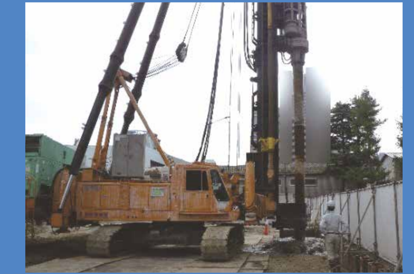
深層混合攪拌状況
