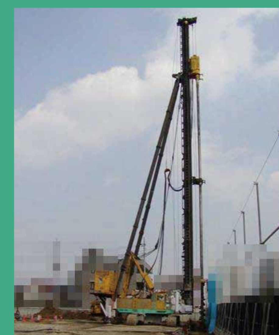
遮水壁設置状況
