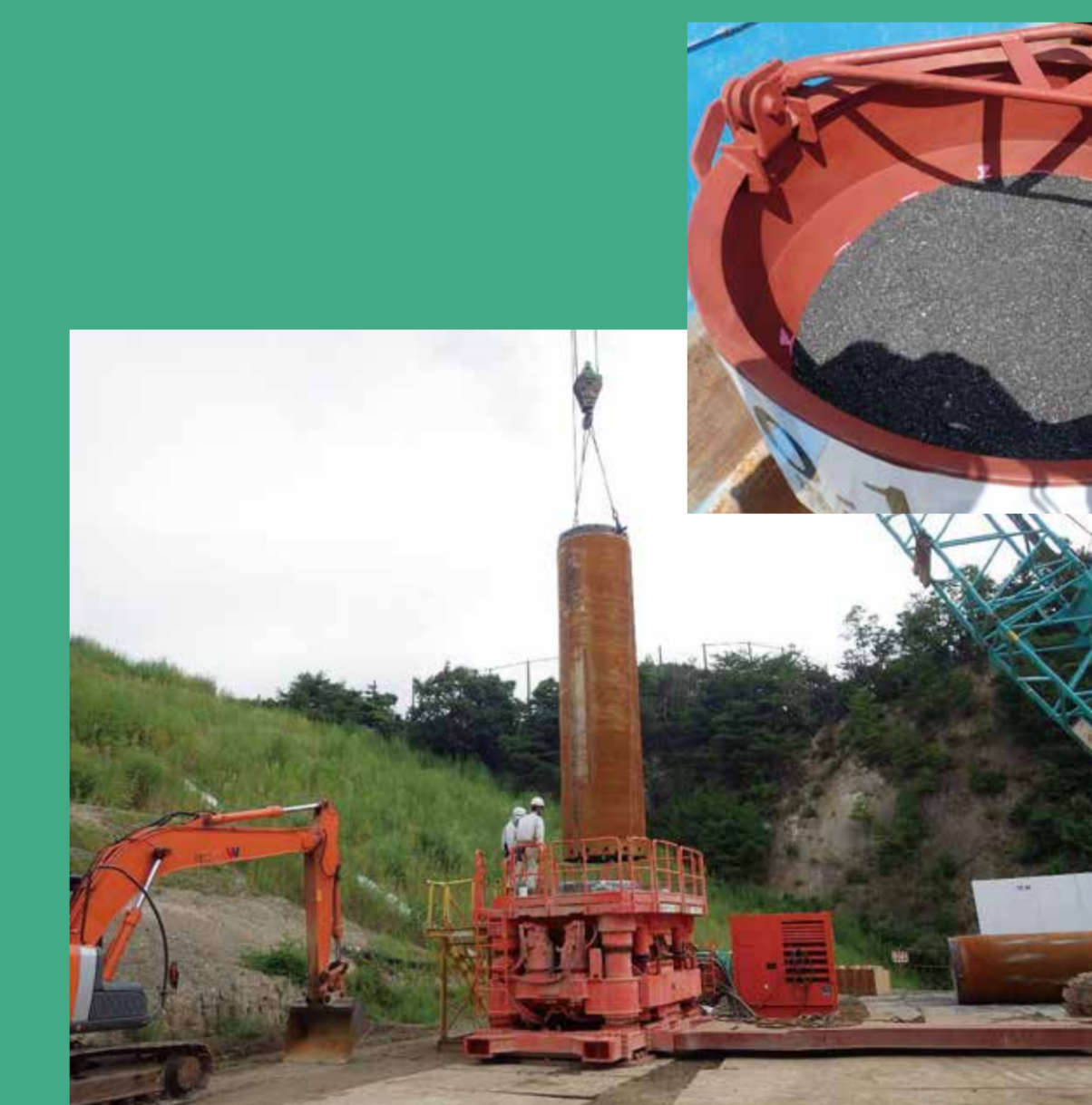
透過壁 (ケーシング) 設置状況
