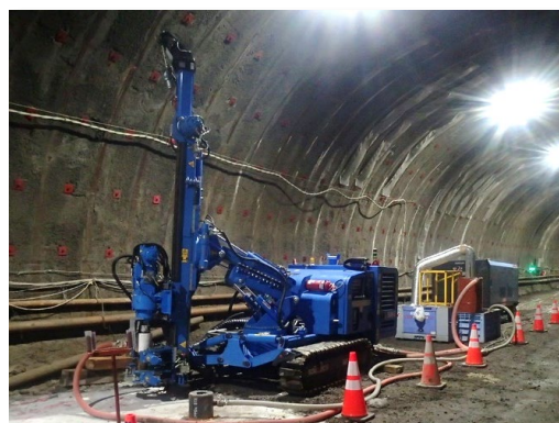
実トンネル内での試験施工状況
