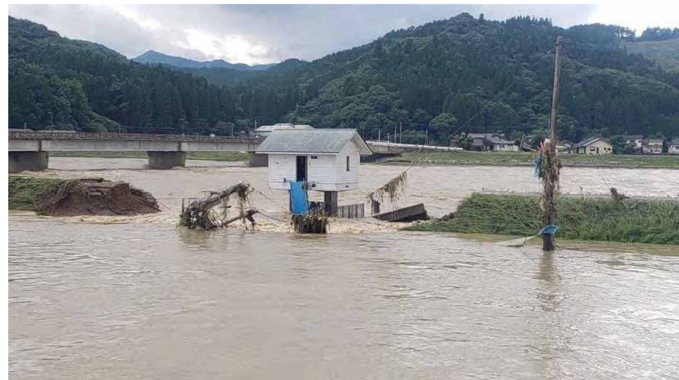
令和2年7月豪雨被害（球磨川、熊本県）
