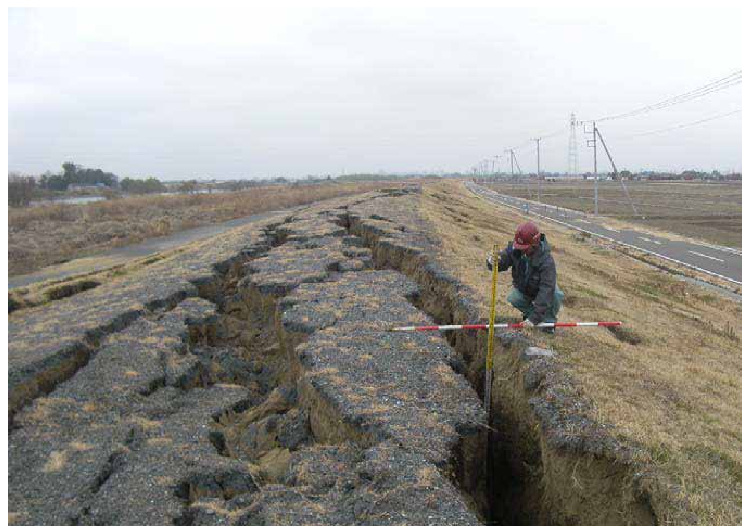
堤防地震被害（那珂川、茨城県） 出典：直轄河川緊急復旧工事実施状況（平成23年東北地方太平洋沖地震による河川被災箇所）、国土交通省 関東地方整備局河川部
